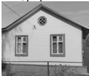
Рис. 1. Слуховое окно на двускатной крыше г. Серпухов, ул. Узловая, д. 9 4
